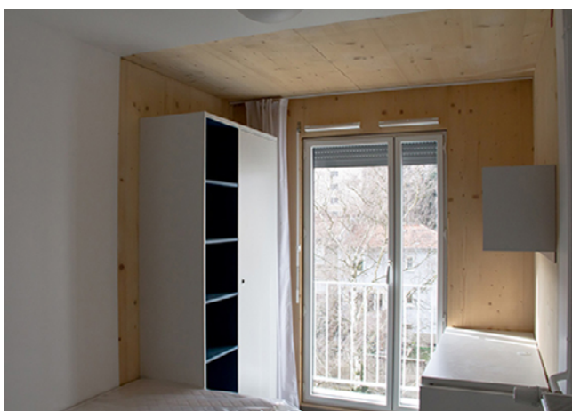
Augmentation de la surface des chambres du CROUS de Nancy grâce à des plugs en structure bois (Sylvia Griño - Agence Barthélémy Griño Architectes)
