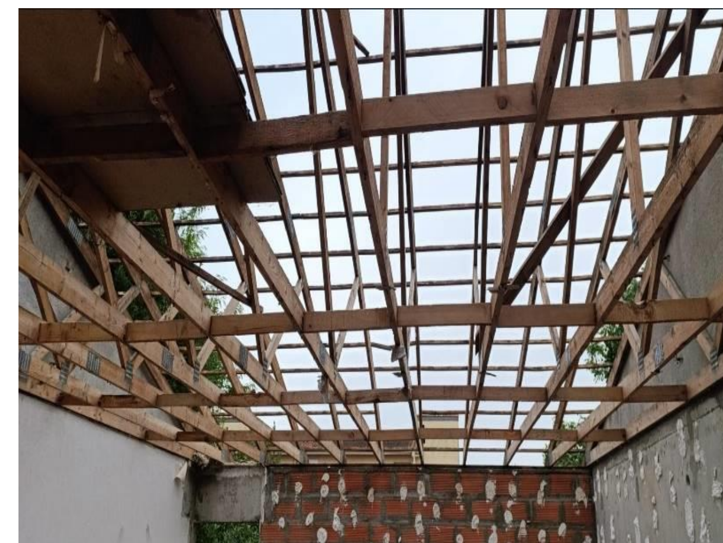
Charpentes en fermettes du chantier de Clos de Vergnes
