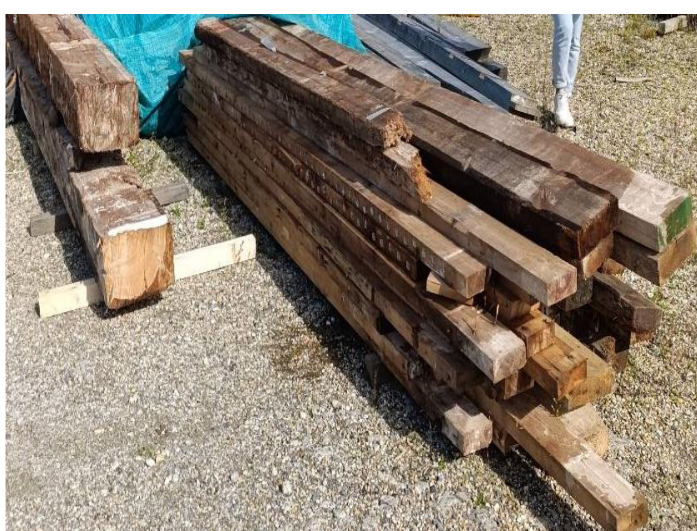
Récupération des éléments en bois du chantier de la rue Naujac
