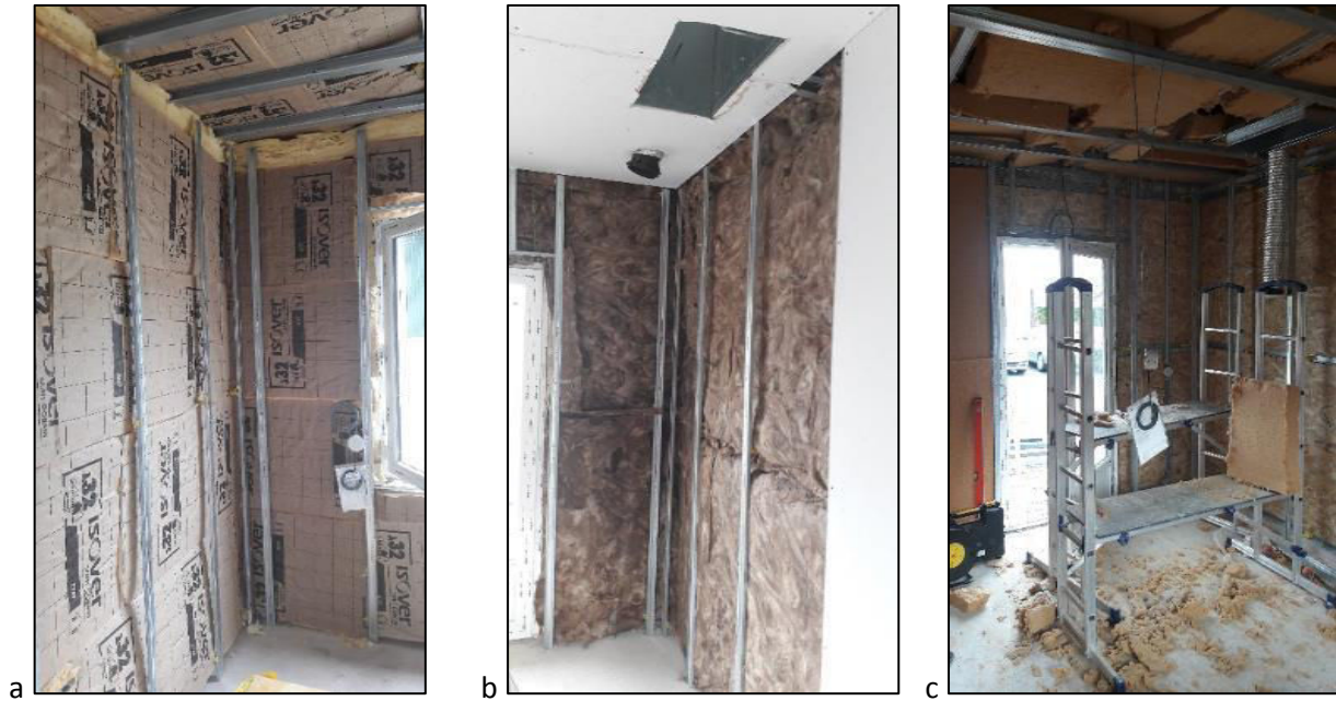
Figure 6 : Pose de l'isolation et des plaques de plâtre dans les modules a) « classique », b) « naturel » et c) « peu émissif »
