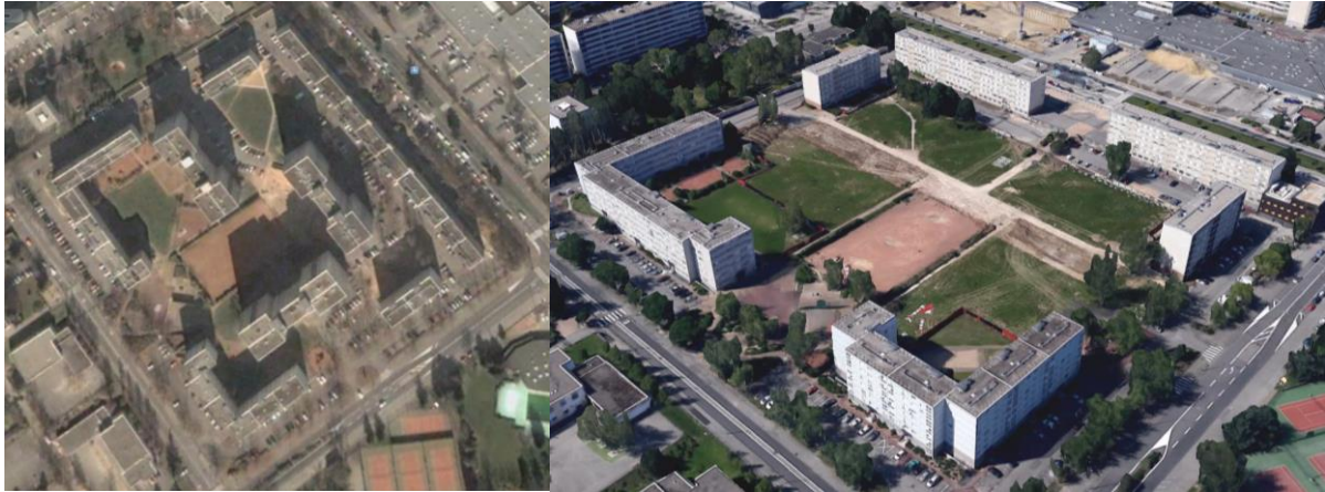
Figure 47 - Quartier Armstrong état initial (gauche) et après démolitions (droite)
