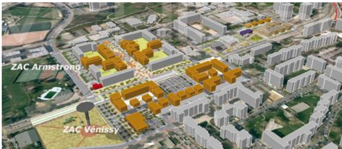
Figure 46 - Opération de renouvellement urbain du plateau des Minguettes, Vénissieux
