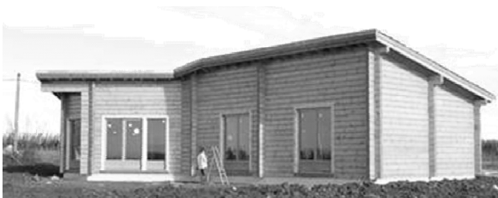
Bâtiment de Bureaux, Vue général
