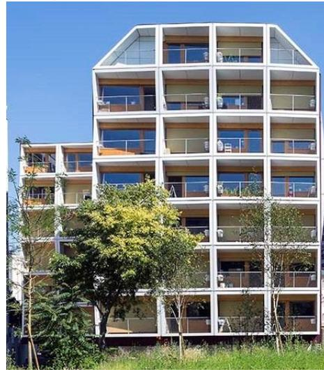
Figure 10 : Bâtiments multiétages en poteaux-poutres bois
