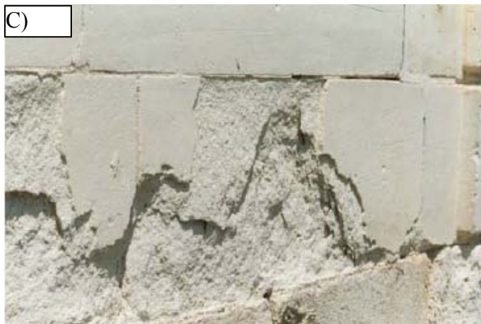
Figure I-7 : Photos de dégradations de la pierre : croûtes noires formées sur une pierre non poreuse (A1), ou poreuse (A2); Alvéolisations et désagréations sableuses (B1-B2) ; Altération en plaque (C) (Beck, 2006).
